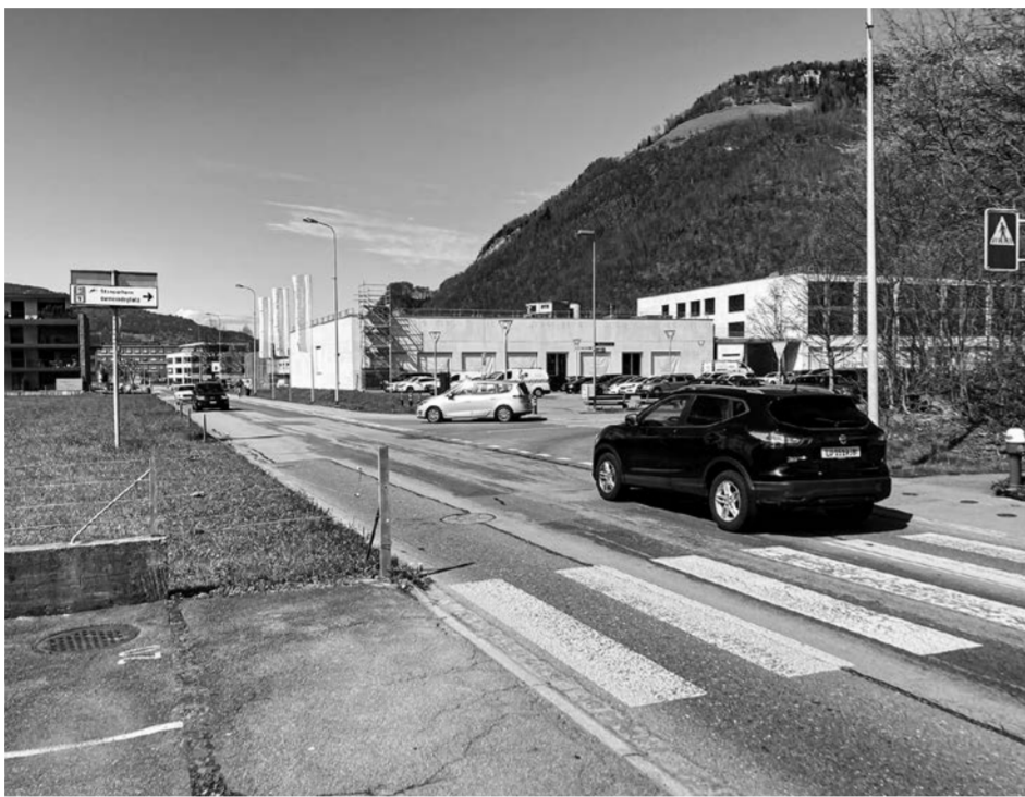
Die Robert-Durrer-Strasse muss komplett saniert werden.
