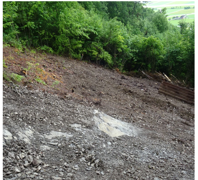
Abbildung 8: Ansicht Fussbereich der vormaligen Rutschmasse. Im Vordergrund ist der anstehende Fels erkennbar. Im Hintergrund ist das flächig lagenweise eingebautn Material erkennbar. Zudem sind am rechten Bildrand die temporär als Abrollschutz gestellten Stahlpalisaden ersichtlich, 06.05.2025.
