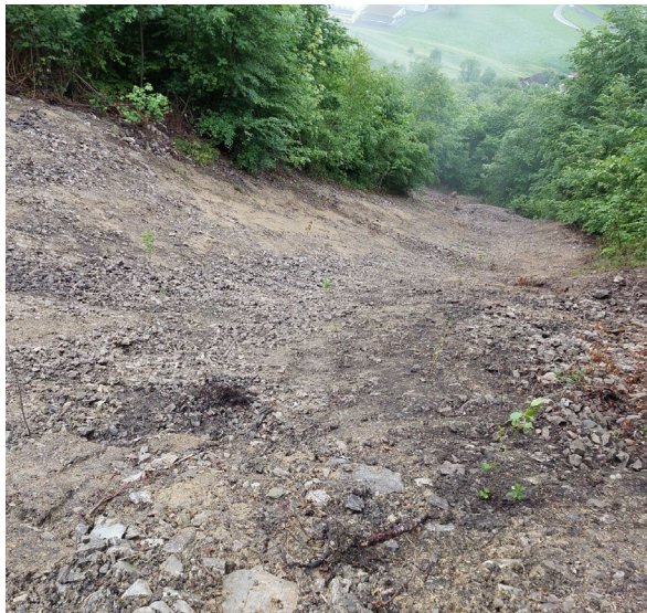
Abbildung 7: Blick über die abgebaute Hauptmasse der Rutschung hinunter zum Fuss, die Stecklinge sind erkennbar, 13.05.2025.
