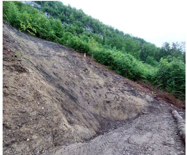
Abbildung 6: Blick zum vormaligen zentralen Depot und Anrissbereich nach abgeschlossener Arbeit, 13.05.2025. Die Zufahrtspiste / Berme mit durchlässigem Material ist erkennbar. In der Rutschfläche wurden Stecklinge und eine Saat aufgebracht.
