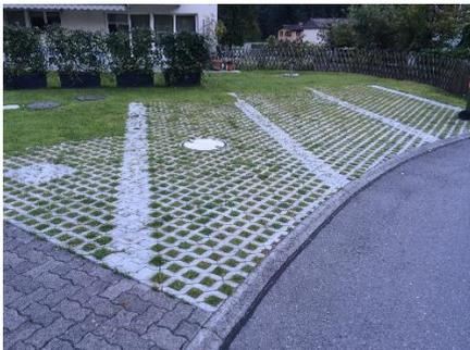
*Gemischte Belags- und Sickerstein-Flächen mit zusätzlicher Entlastung in eine begrünte Bodenschicht*
