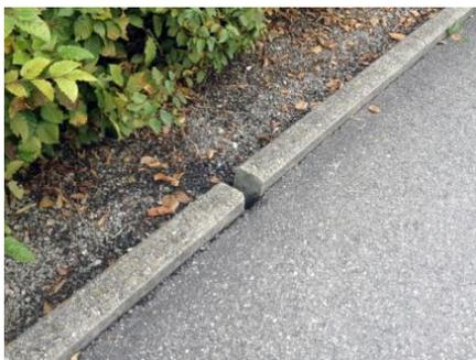
*Als flache Mulde ausgebildete, mähbare Versickerungsfläche mit oberirdischem Zulauf*
