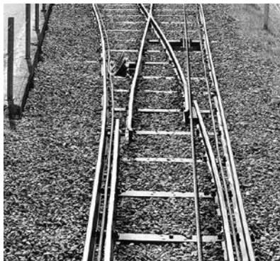
Kostengünstige Ausweiche und Radachsen nach dem System von Ing. Roman Abt.
