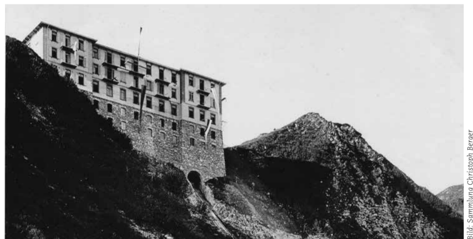
Fahnschmuck zur Eröffnung: Noch ist das Hotel nicht fertig gebaut.
