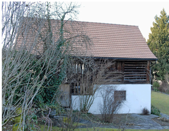
Bild oben: Ansicht von Nordosten Bild unten: Ansicht von Südosten
