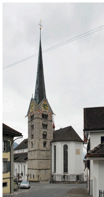
Bild oben: Ansicht von Nordwesten
